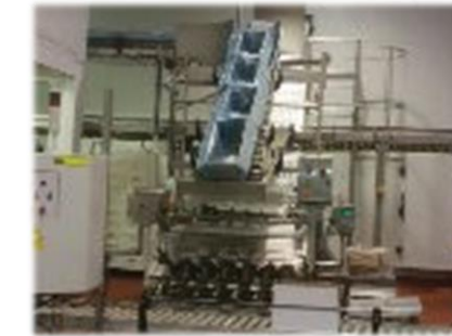
Installations de manipulation pour le transport de boîtes
